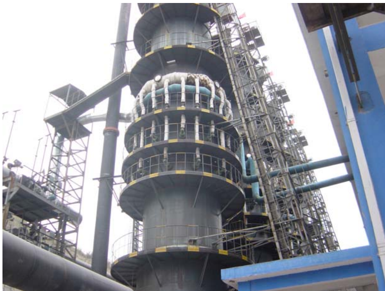
涡流式煤气烧嘴在西宁特钢高炉石灰窑生产现场
